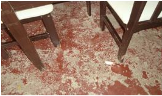
Figura 9. Piso desgastado
