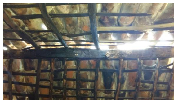
Figura 8. Terças, caibros e ripas imunizados contra o cupim
